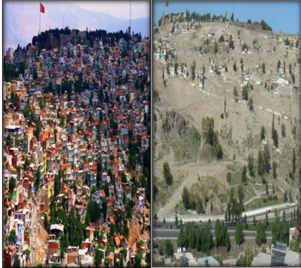
Şekil 2. İzmir Kadifekale kentsel dönüşüm bölgesinde yıkım öncesi ve sonrası görüntüler
