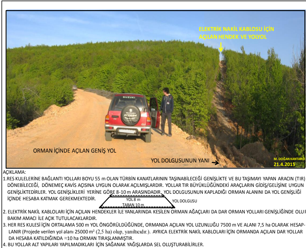
Şekil 11. RES kulelerine bağlantı yolu ile elektrik nakil kablo yolu
