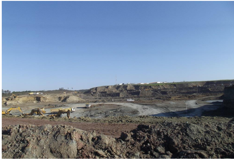
Şekil 2. Havalimanındaki hafriyat çalışmaları
