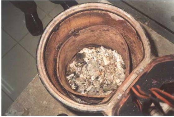
Fotoğraf 7. Parça kömürün yakılması sonucu oluşan yanma kamarası
